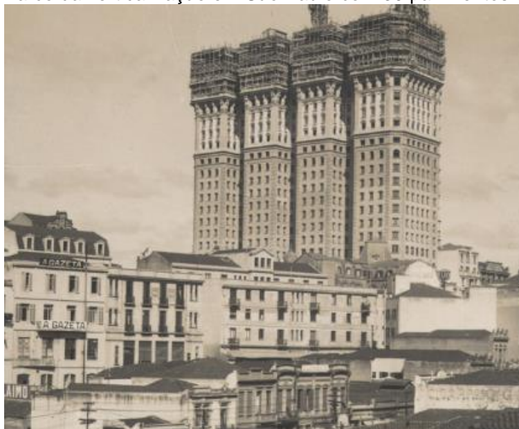
Figura 39: Edifício Martinelli na época da construção em 1924 Representou o marco da verticalização em São Paulo com 30 pavimentos e 110m de altura
