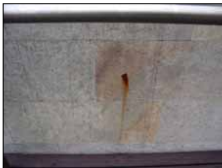
Figura 9. Sviluppo di macchie localizzate in un muro esterno. - Development of located patches in an external wall.
