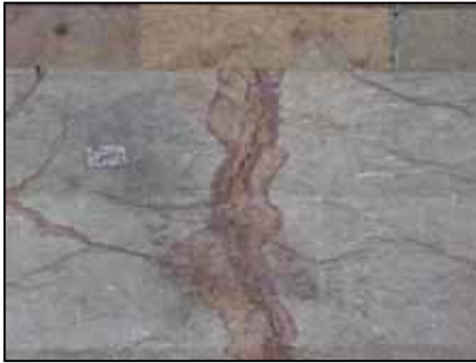
Figura 6. Processi di rottura e fessurazione. Scale nel “Centro Administrativo La Alpujarra”.
