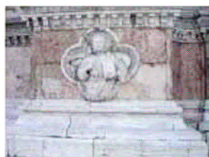
Figura 2. Materiali lapidei delle costruzioni stoiche dell' Emilia Romagna, a Bologna ed esempi di deterioramento. (a) Arenaria e calcare detto Veronese, nel Palazzo Comunale, che mostra la dissoluzione; (b) Calcarei fossiliferi nella Basilica di San Petronio (Pietra d'Istria e calcare a dischi rossi) che mostra la dissoluzione e l'alterazione del colore; (c) arenaria che mostra idrolisi e dissociazione.
