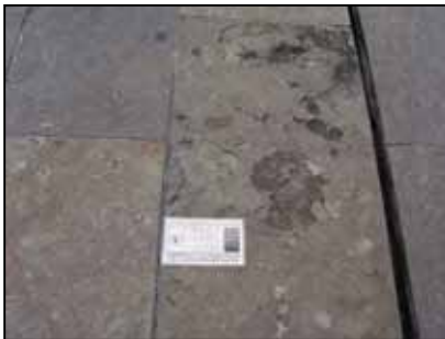
Figure 7. Processo di singola e multipla sfaldatura, pavimento esterno del “Centro amministrativo La Alpujarra” - Single and multiple flaking processes, external floor of the “Centro administrativo La Alpujarra”.
