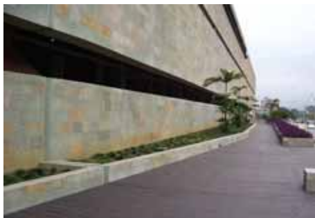
Figura 4. Uso dei calcari RV e RVt nella facciata del “Centro de Exposiciones” - Use of RV and RVt limestone in the facade of “Centro de Exposiciones” Medellín, Colombia.
