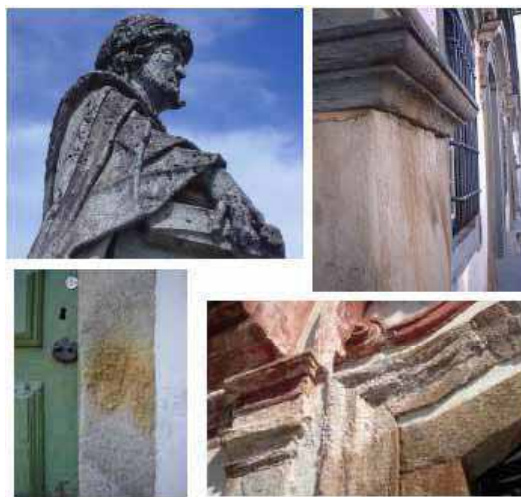
Figura 1. Materiali lapidei delle costruzioni storiche di Minas Gerais ed esempi di deterioramento. (a) Steatite con calcite e clorite in una scultura all'ingresso della chiesa di Bom Jesus do Matosinhos a Congonhas do Campo/MG. Si vedono l'alterazione del colore, le macchie e le cavità dovute alla dissoluzione dei carbonati.; (b) Granada - cianite – mica scisto e quarzite, nel dettaglio del Museo di Arte Sacra di Mariana, Minas Gerais, che mostra un'erosione differenziale; (c) Granito del portale della Chiesa di Cachoeira di Campo con ossidazioni; (d) Quarzite del portale del Cimitero di a Ouro Preto, che mostra processi di efflorescenza e dissoluzione.
